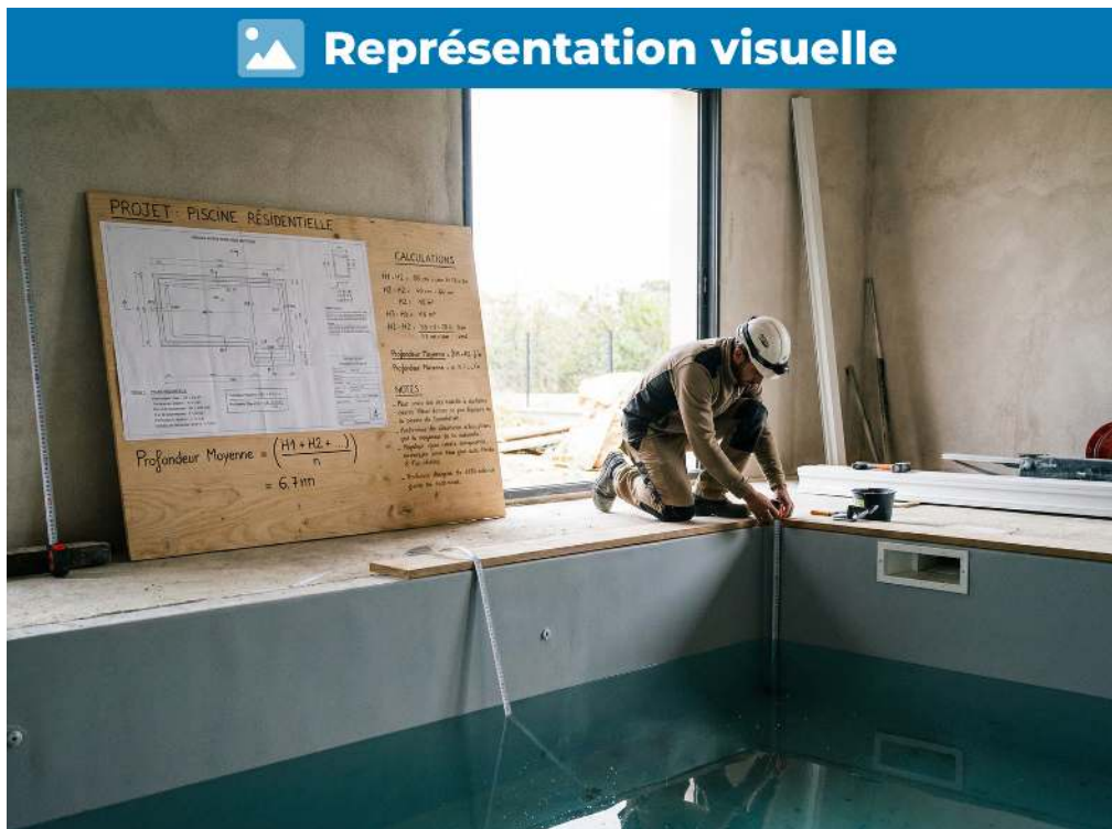
Calcul de profondeur moyenne: mesurer avec un mètre ruban pour une piscine de 12 m x 6 m
