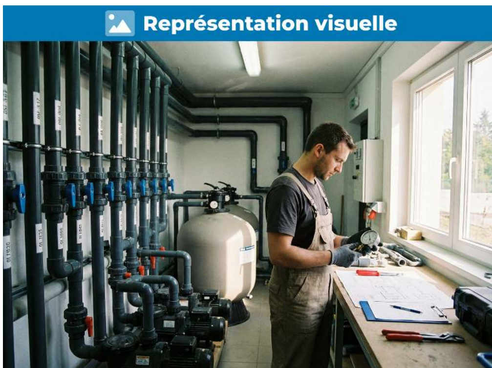
Contrôle de pression à 1,5 bar, étape essentielle pour assurer l'étanchéité du circuit
